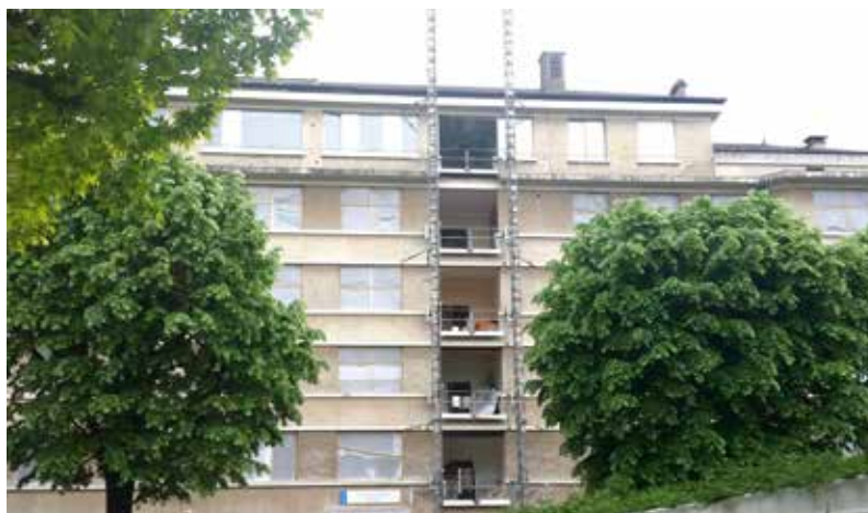
Rénovation bâtiment Larrey B à Avicenne
