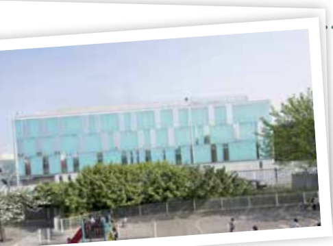
L'extension du bâtiment Larrey B à Avicenne
